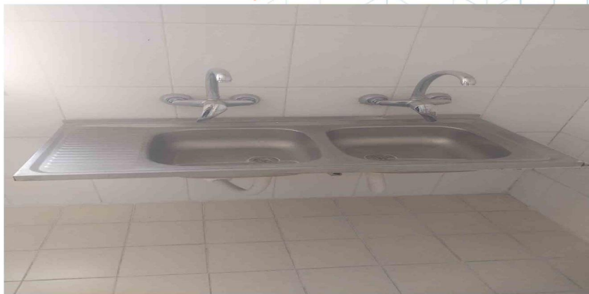
نصب شیرآلات و سینک جدید در آشپزخانه
