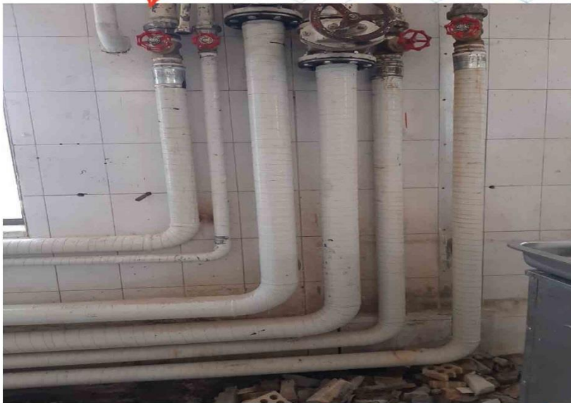
اصلاح و ترمیم کلیه سیستم لوله کشی آشپزخانه مرکزی
