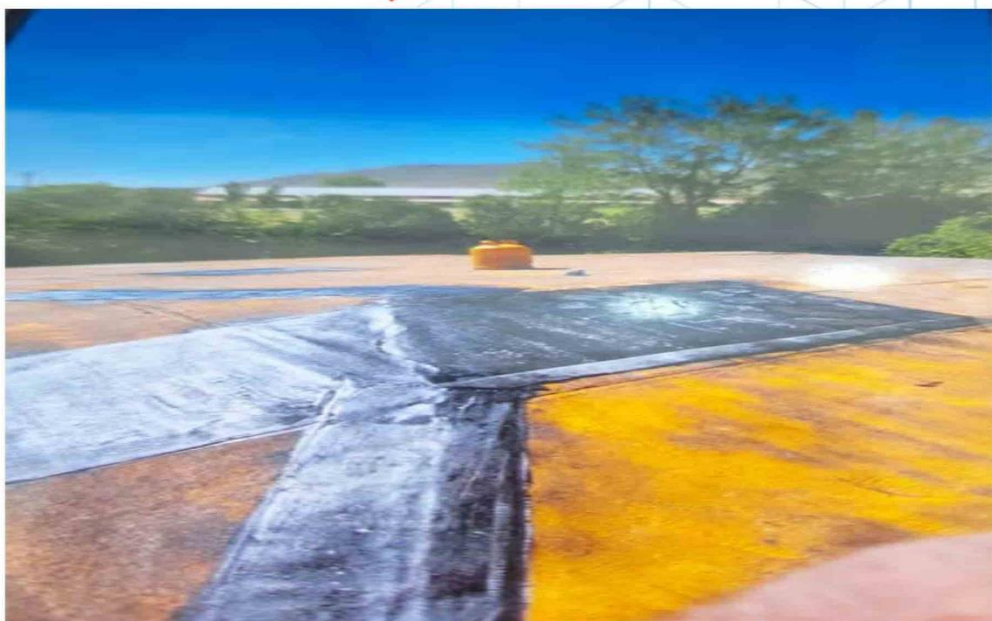
ایزوگام مجدد پشت بام خوابگاه ها
